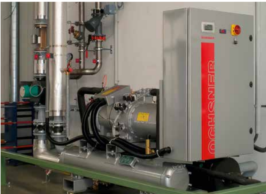
Wärmepumpe in einem Aluminiumbetrieb. Durch den Einsatz der Wärmepumpe kann das Wasser, das durch die Prozesswärme beim Aluziehen auf 25°C erwärmt wird, für Heizzwecke genutzt werden.
