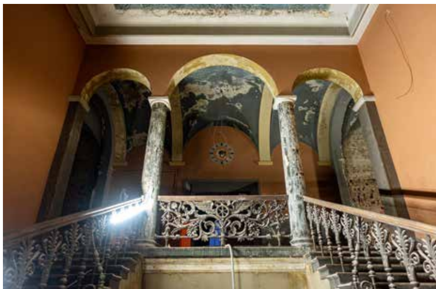
Das historische Treppenhaus am Osteingang.
